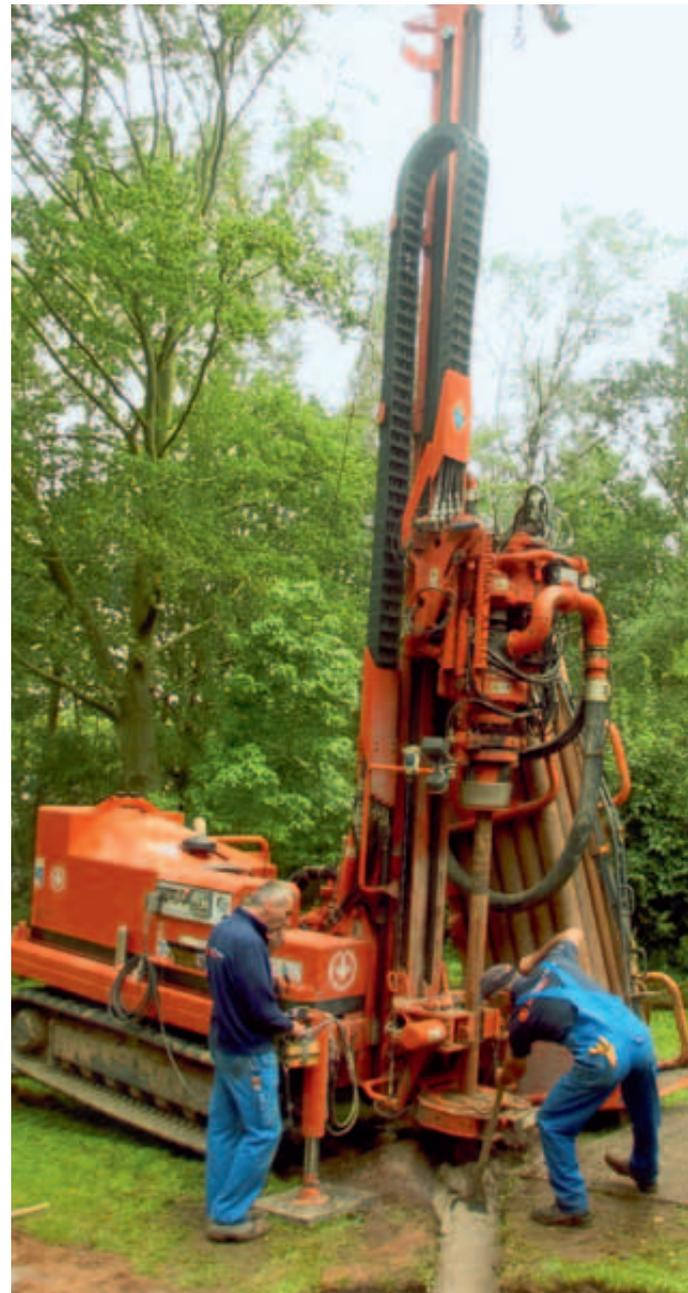
Abbildung 80: Bohrarbeiten zur Installation von Erdwärmesonden.
